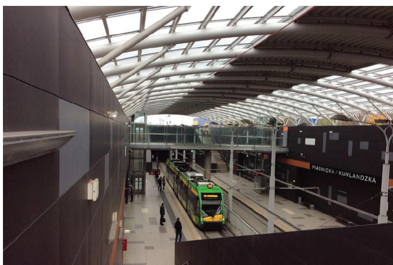
Budowa trasy tramwajowej Os. Lecha-Franowo
